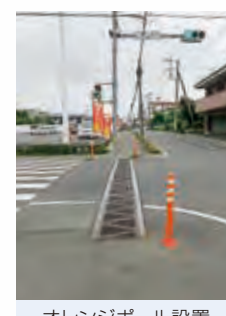
オレンジボール設置
